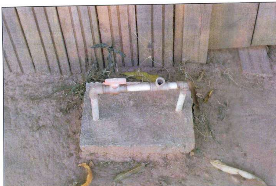
Figura 36 - Ligação domiciliar de água.
