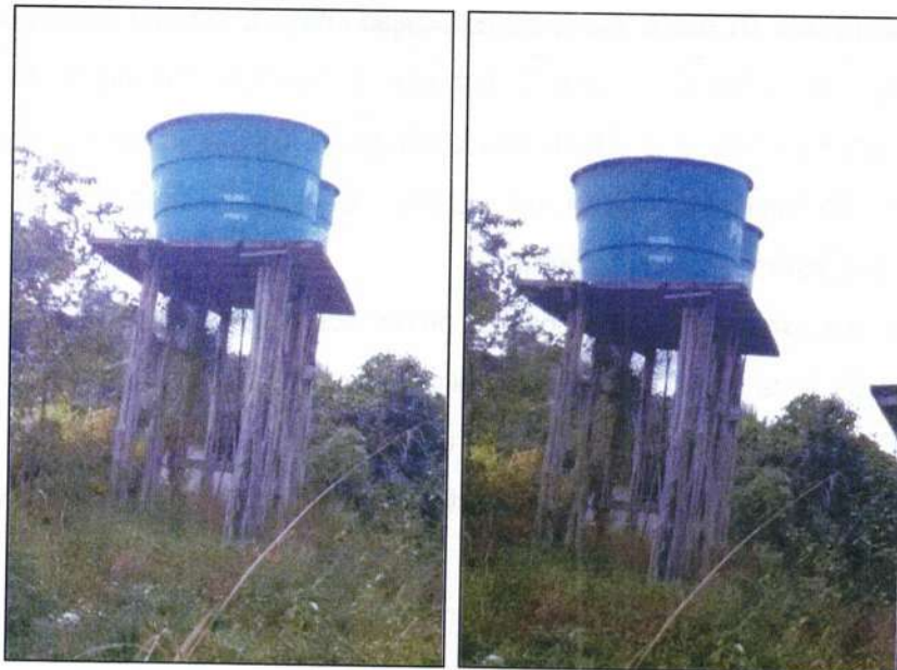
Figura 104 - Reservatórios elevados Fortlev PRFV.
