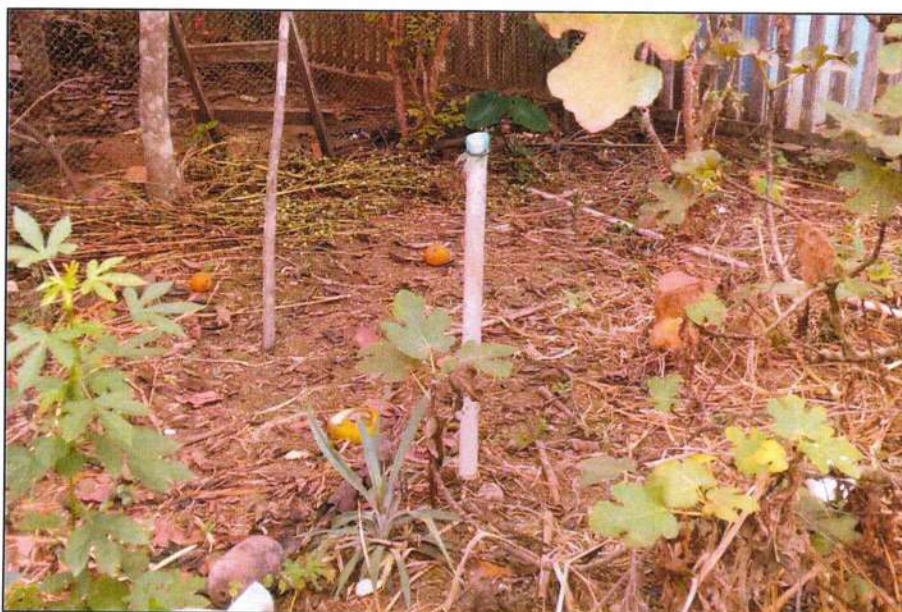
Figura 118 - Fossa negra (rudimentar) individual com respiro.
