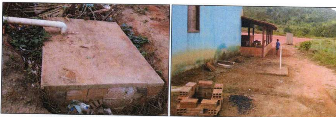
Figura 133 - Fossa negra (rudimentar) individual com respiro.
