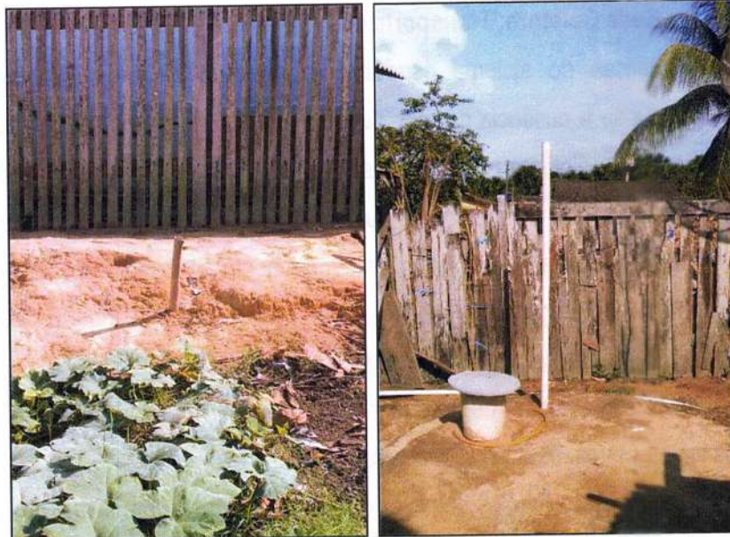
Figura 41 - Tubulação de respiro de fossa negra.
