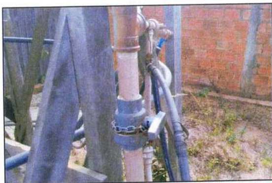
Figura 24 - Registro do poço (1) e tubulação de distribuição.
