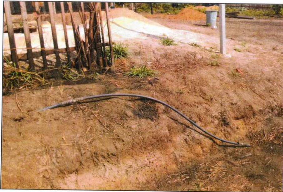
Figura 34 - Tubulação de distribuição na margem da rua.
