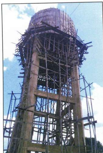
Figura 27 - Reservatório (1) em construção (capacidade de 100 m 3 ).
