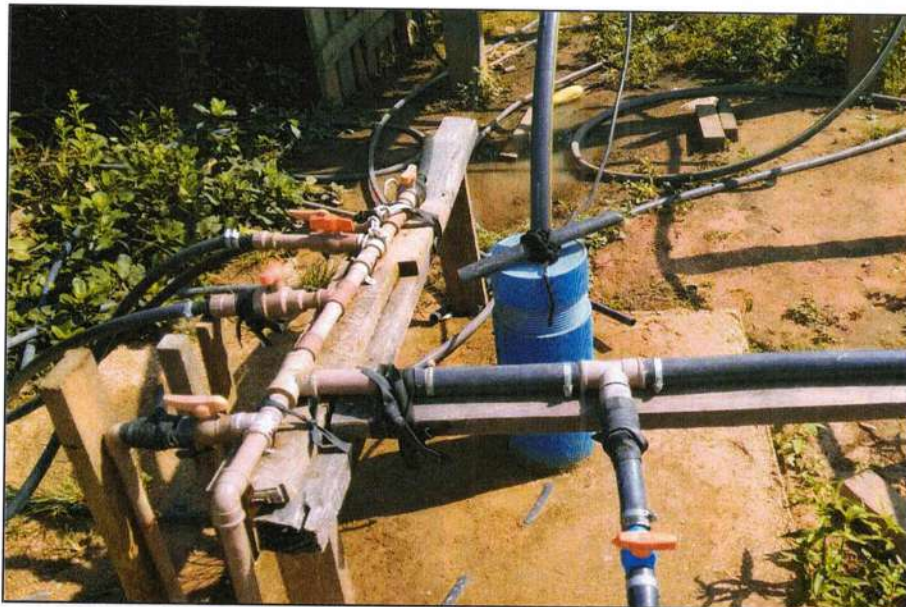
Figura 32 - Poço tubular profundo (3) e tubulação de distribuição.
