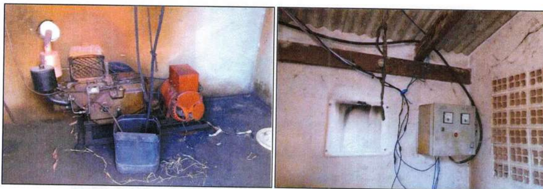
Figura 97 - Casa de Bombas e Quadro de Comando.
