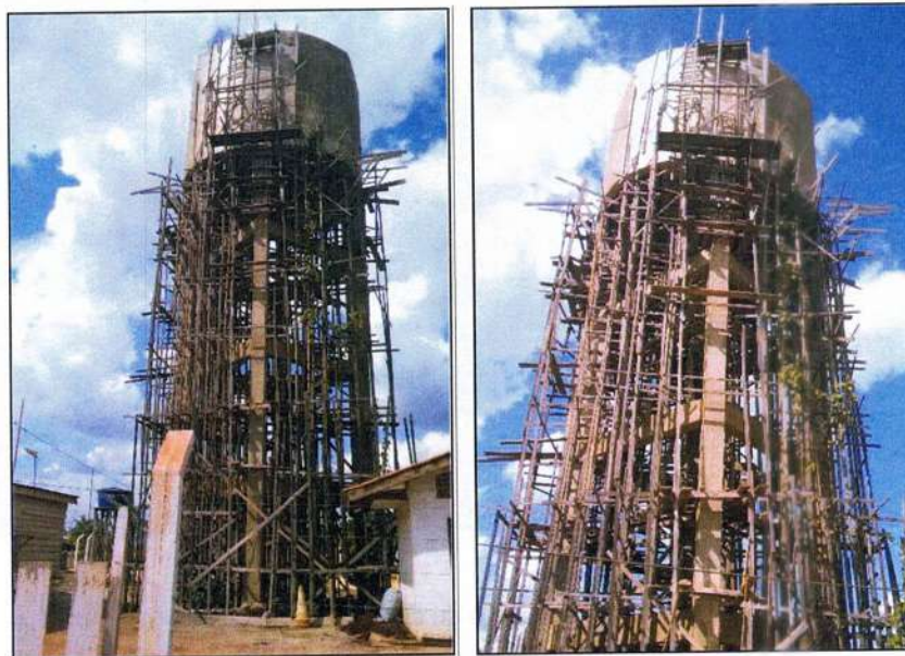
Figura 31 - Reservatório (2) em construção (capacidade de 100 m 3 ).
