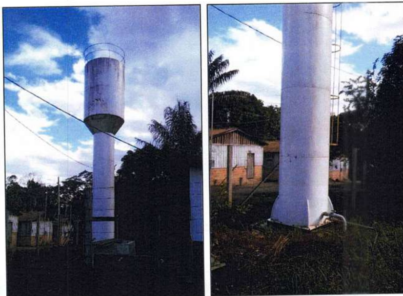
Figura 95 - Reservatório Elevado Metálico.
