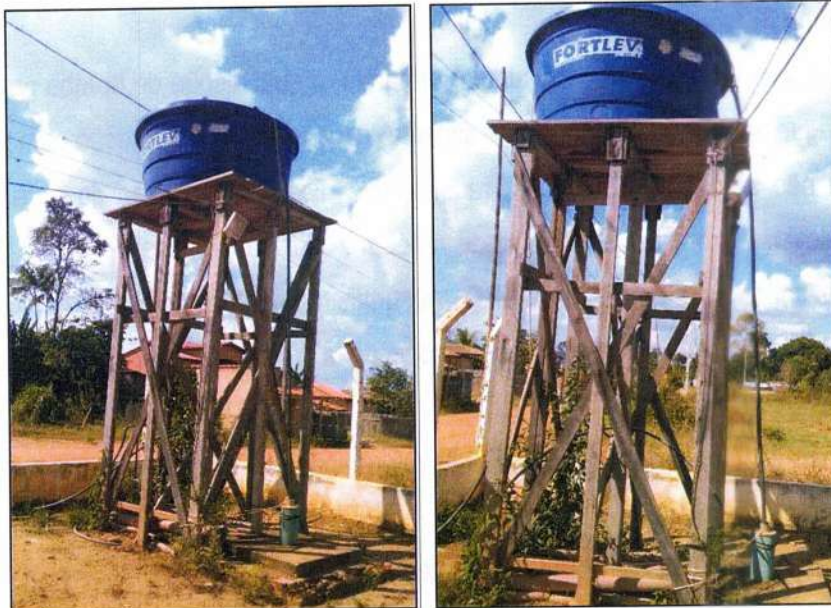
Figura 30 - Reservatório temporário (capacidade de 2 m 3 ).
