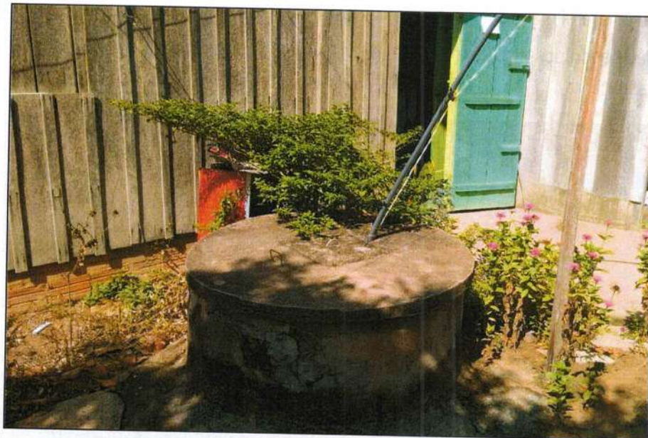
Figura 21 - Poço raso individual na área urbana (b).
