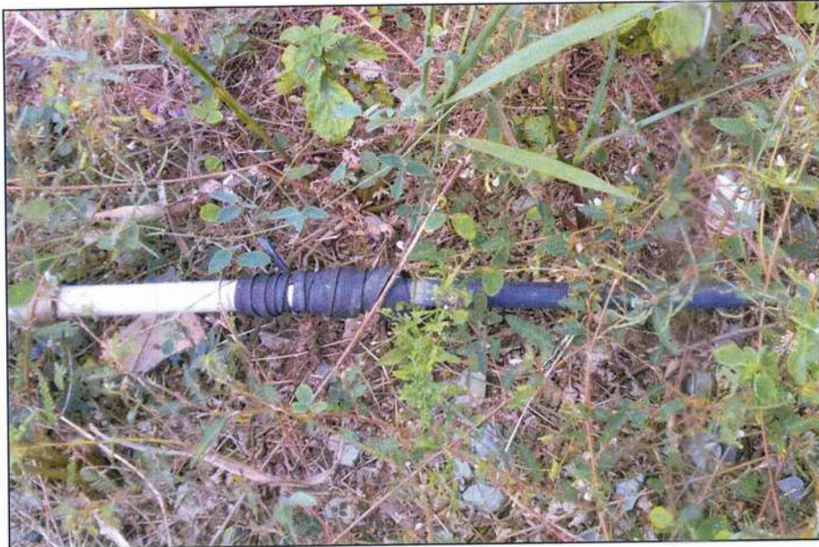
Figura 84 - Ligação domiciliar na saída do reservatório.
