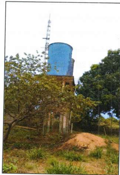
Figura 168 - Reservatórios de 20.000L do microsistema inoperante.
