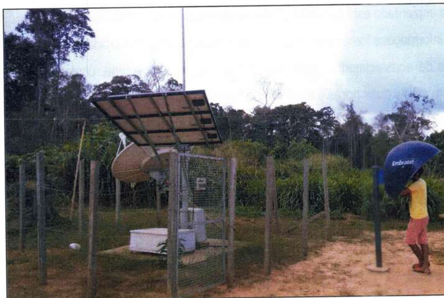
Figura 92 - Orelhão Embratel e placa de energia solar do orelhão.
