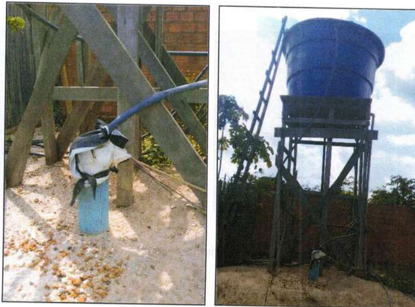
Figura 26 - Poço (1) e Reservatório temporário (capacidade de 5 m³).
