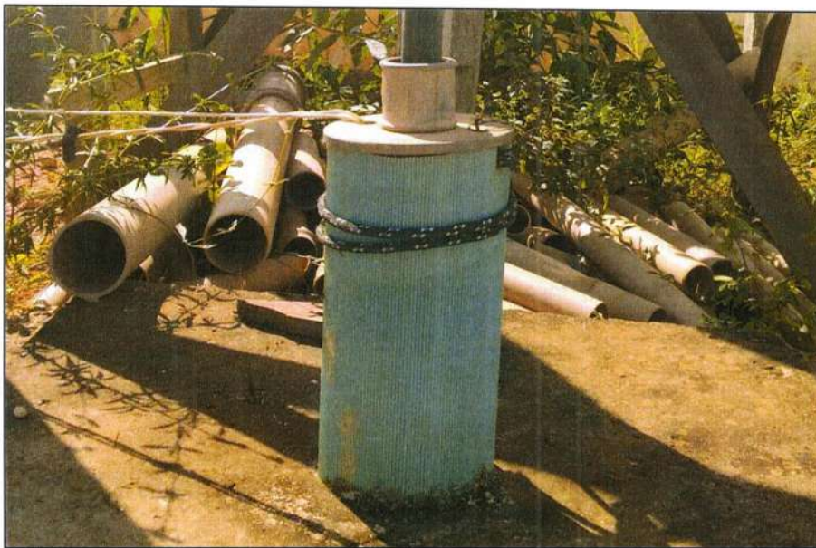
Figura 29 - Poço tubular profundo (2).
