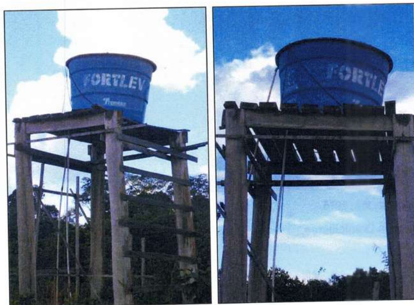
Figura 96 - Reservatório Elevado Fortlev PRFV.
